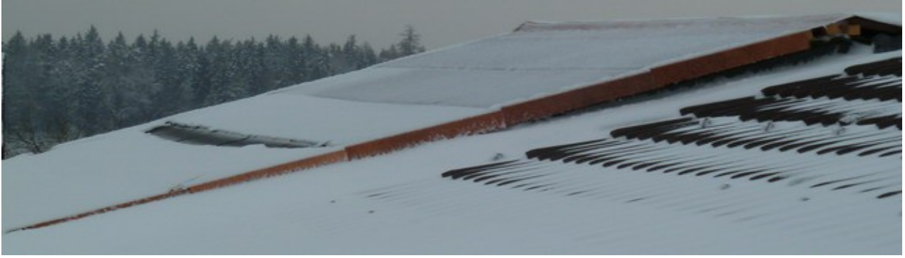
Foto 3 und 4 20. Dez 2011 Der neugefallene Schnee rutscht innerhalb eines Tages vollständig vom Dach. Dämmung des Estriches, 200mm Styro
