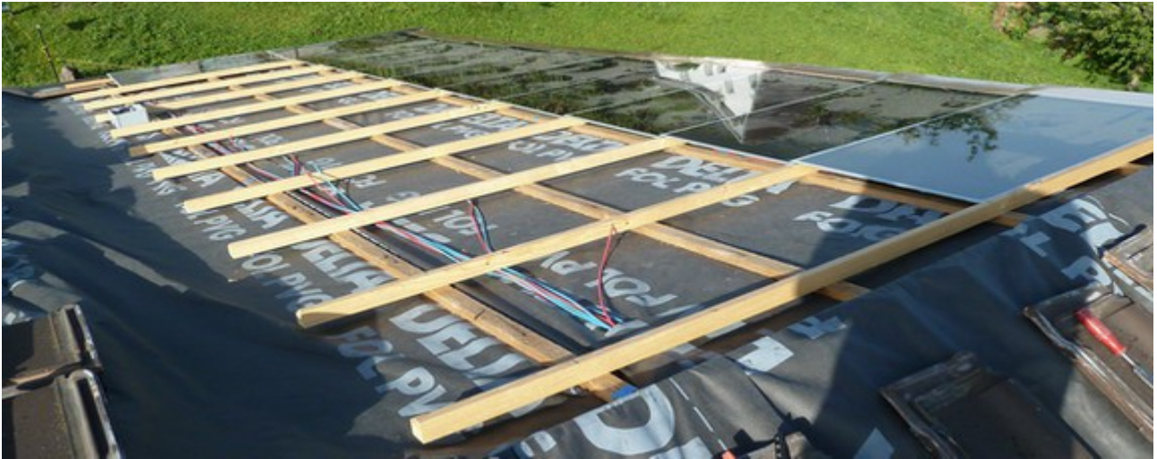
Foto 1 23. August 2011 erste Bahn fertig
