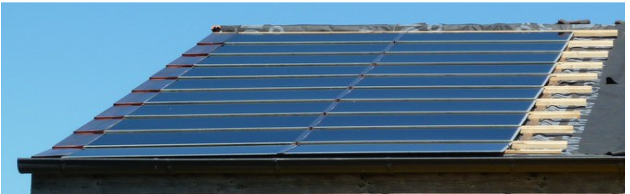
Foto2 28. August 2011 zweite Bahn fertig
