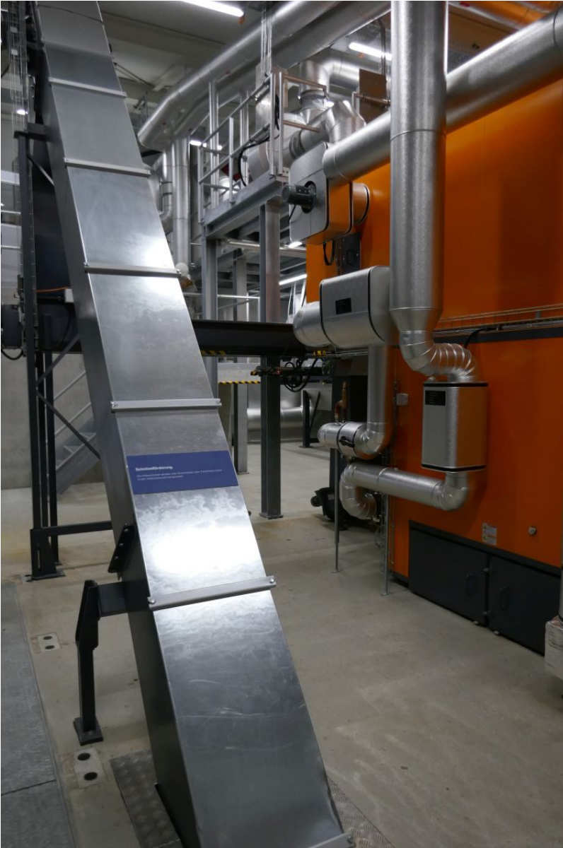
Durch diesen Kanal werden die Schnitzel in die Öfen gefördert.
